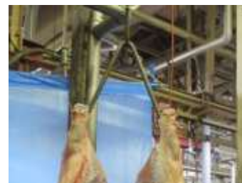
(写真 23) 懸吊する
