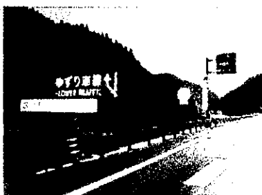
【ゆずり車線の状況】
