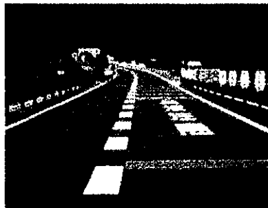
合流注意の路面文字表示 薄層カラー舗装 防眩板を利用した注意喚起看板
