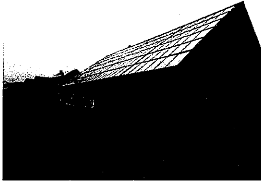
写真—74 チップボイラー庫 (地域熱供給は太陽熱も併用)
