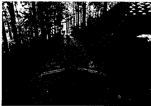
写真-9 雨天時でも水たまりのない かまぼこ型林道(AUSTROFOMA2015)
