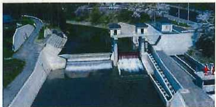
農業用河川工作物等応急対策により整備された頭首工
