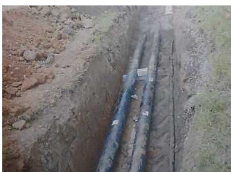
写真—66 熱供給パイプの埋設状況
