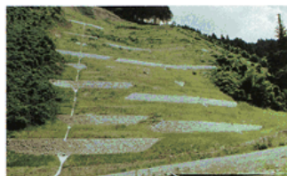
崩壊地の復旧を図るため、山腹工を実施し森林の機能回復を図った。(昭和49年)
