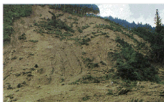
豪雨により山腹崩壊が発生し、森林が著しく荒廃した。(昭和47年)
