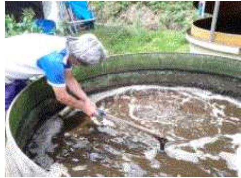
写真6 散気管取り替え作業
