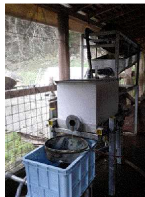
写真4 流量調整槽の設置
