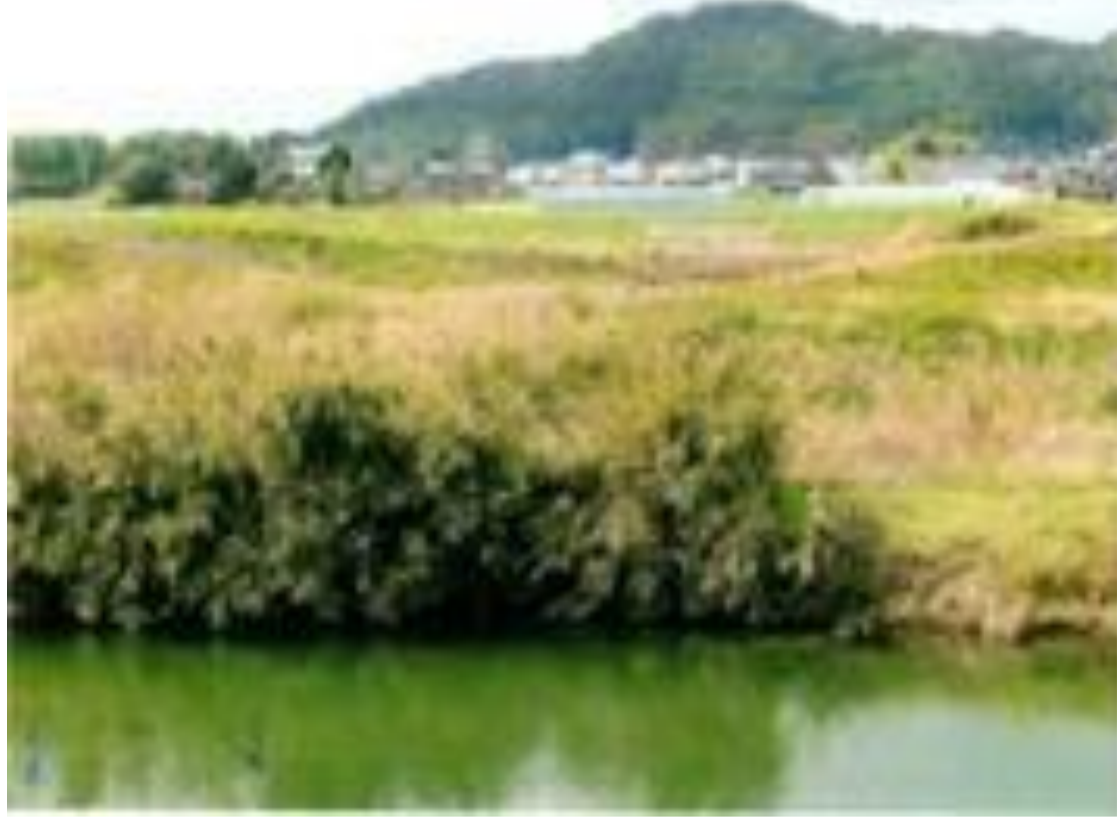
佐賀県城原川の野越し、堤防の天端が下がり越水する
