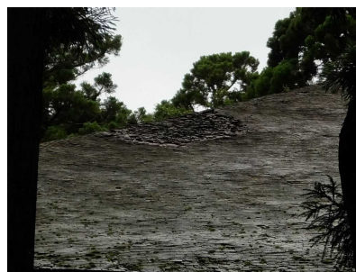
こけら葺き屋根の劣化の様子
