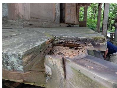
縁板の腐朽箇所
