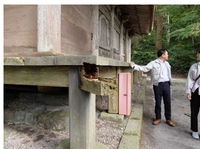
縁隅木の腐朽箇所
