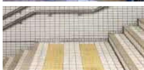
段鼻のステンレス部分が細く、段鼻の視認性が低くなっています。
