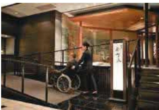
傾斜路の立ち上がりは明度の低い黒色に、傾斜部分は明度の高い灰色とし、明度によるコントラストを設けています。
