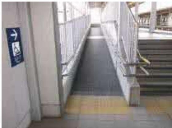
傾斜路の立ち上がりは明度の高い白色に、傾斜部分は明度の低い灰色とし、コントラストを設けています。
