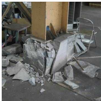
倉吉梨選果場 (支柱破損)
