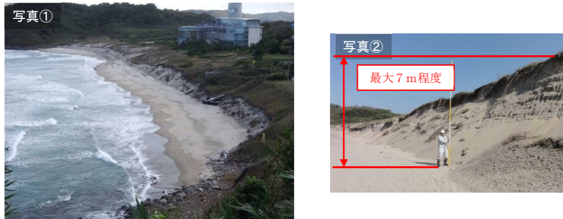
図 7.1.1 井手ヶ浜で発生した浜崖状況（平成26年12月撮影）
