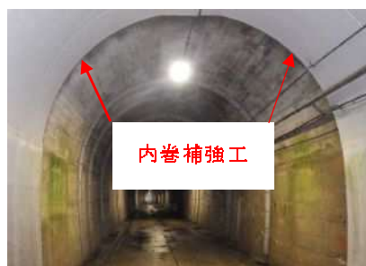
写真2.2 内巻補強工の事例
