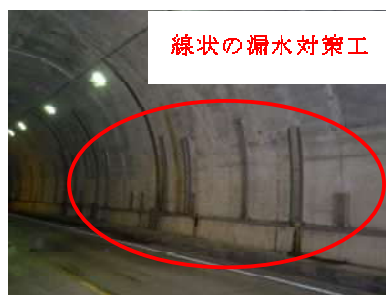
写真2.4 線状の漏水対策工の事例
