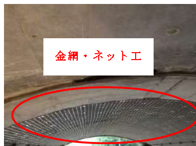
写真2.3 金網・ネット工の事例
