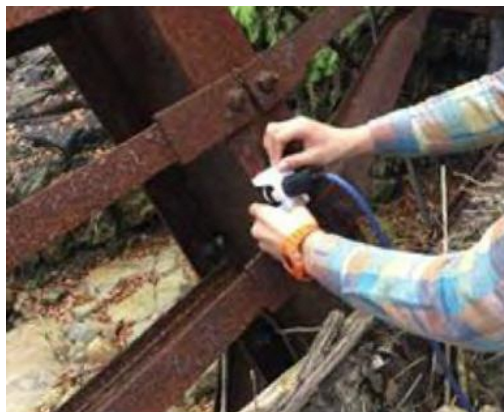
鋼板腐食検査器を使用した調査
