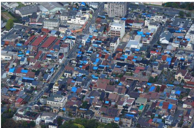
（平成28年11月2日、倉吉市新町周辺（伝建地区））
