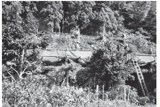
屋根の葺き替え作業 (1999 年、智頭町板井原で撮影)
