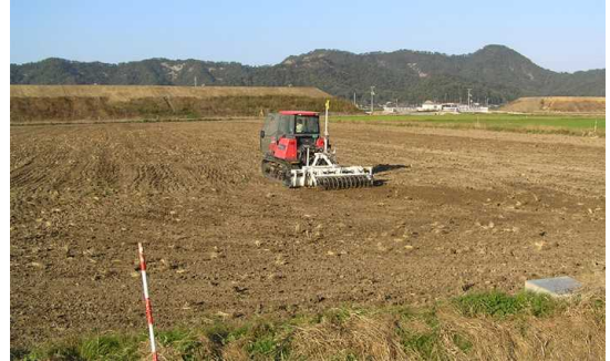
レーザーレベラーによる均平作業
