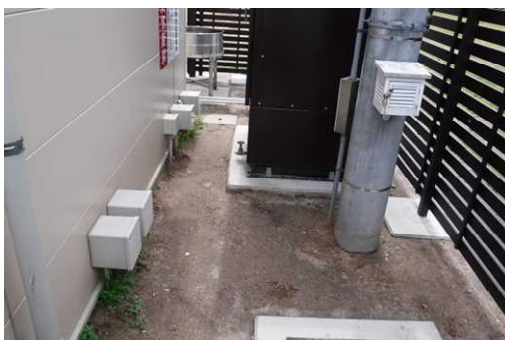
図4 工事後の設置状況（H31年4月）
