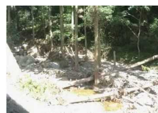
流木化する可能性の高い立木の伐採
