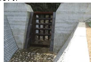
透過型砂防堰堤の新設
