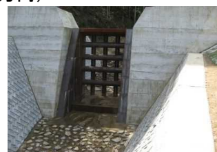
透過型砂防堰堤の新設
