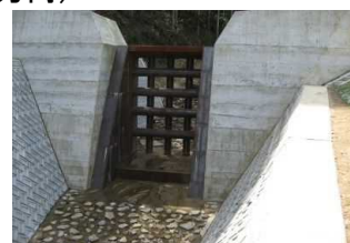
透過型砂防堰堤の新設
