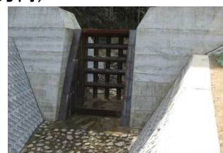
透過型砂防堰堤の新設
