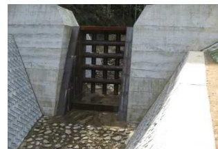
透過型砂防堰堤の新設
