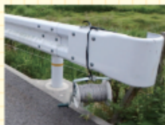
ガードレールに巻き付けられた電気柵
