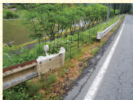
道路沿いに設置された侵入防止柵
