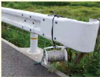
ガードレールに巻き付けられた電気柵
