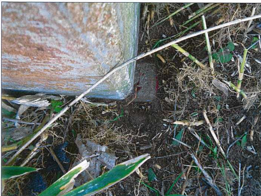
No. 3 標識: コンクリート杭 既存
