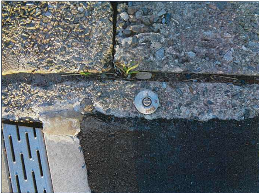
引照点:T-1 標識: 金属釘
