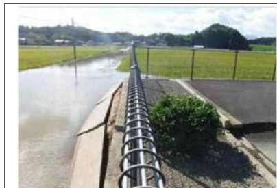
【大倉川の増水により、津原処理区の処理施設が一部隆起】
