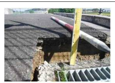
【大倉川の増水により、津原処理区の処理施設が一部隆起】
