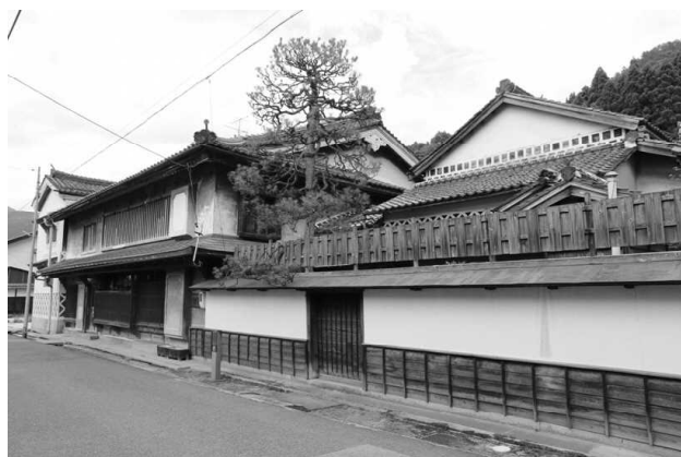
近藤家住宅外観
