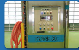
滅菌冷海水(水温3℃) 活松葉がにや活魚取扱用の冷海水 エアポンプ 移動式活魚水槽用のエアポンプ
