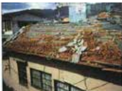
2 屋根瓦中規模被災+外壁小規模被災
