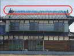
3 屋根瓦小規模被災+外壁中規模被災
