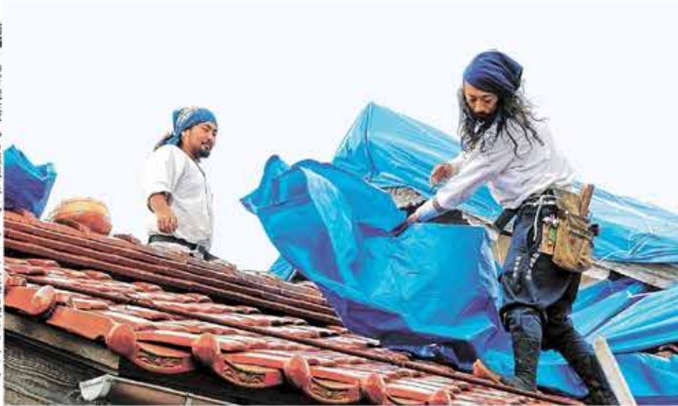
雨漏りの可能性がある屋根にブルーシートを張るボランティア 25日、鳥取県北栄町西園
