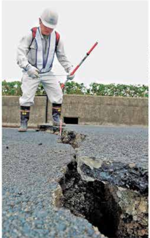
道路の陥没を調べる国土交通省鳥取県川部事務所の職員＝22日午前1時4分、鳥取県北栄町千手
