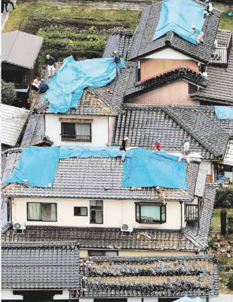
前に傾入、地震で壊れた屋根にブルーシートを張る人たちが22日午前、鳥取県倉吉市元町通保社へりから
