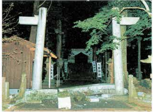
強い地震で被害を受けた多目的ホール。倉吉市で午後2時40分 地震で落ちた神社の鳥居。同市で午後7時半、三浦博之撮影
