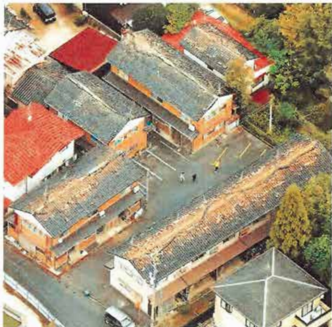
地震で屋根瓦が落ちた建物（21日午後4時31分、鳥取県倉吉市で、本社ヘリから）＝大久保忠司撮影
