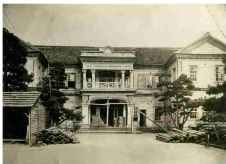
203 傾斜した鳥取県庁正庁舎
