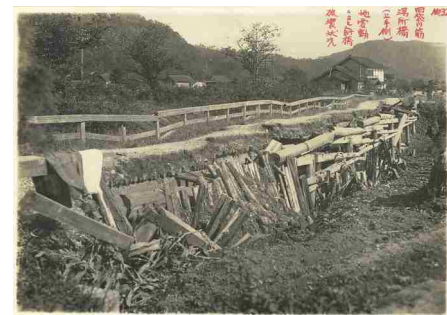
214 旧袋川筋湯所橋
