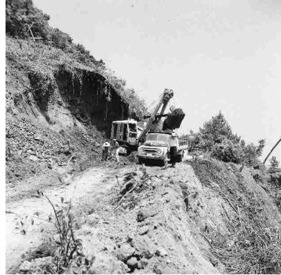
138 国道9号線の付け替え工事
