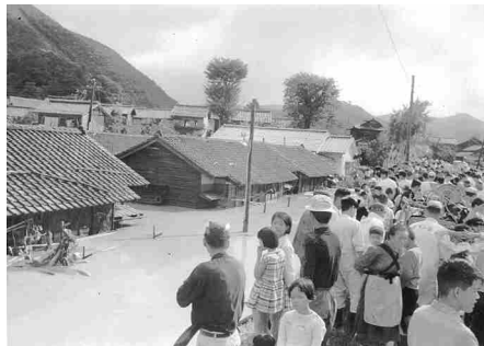
110 水没した住宅
