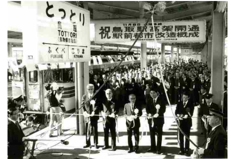
126 山陰線高架工事の完了
