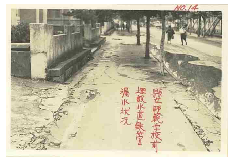
199 師範学校前埋設水道鉄管漏水状況
