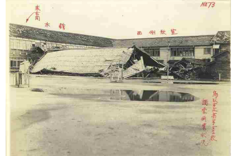
202 鳥取市立高等女学校講堂倒壊状況
