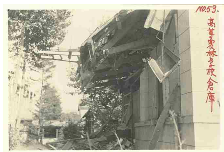
216 高等農林学校倉庫
