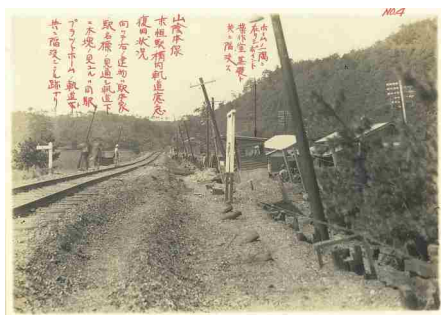
206 末恒駅構内軌道応急復旧状況
