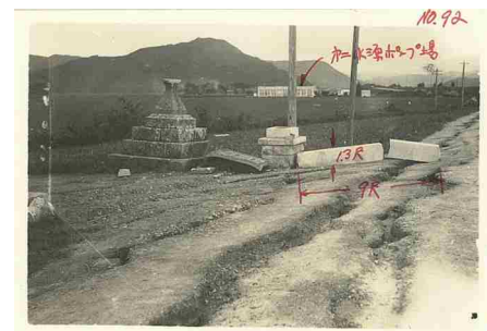
211 第二水源ポンプ場
