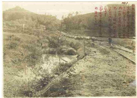
207 白兔宝木間陥没箇所
