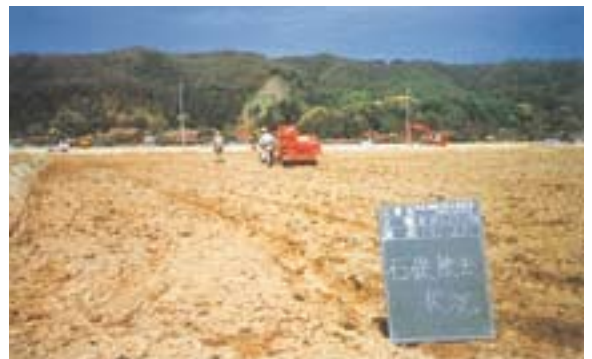
12 石礫除去終了、ほ場出来上がり
