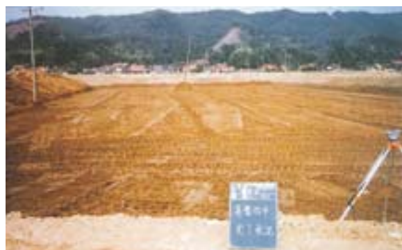
④ 基盤均平完了
