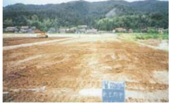
8 表土均平完了
