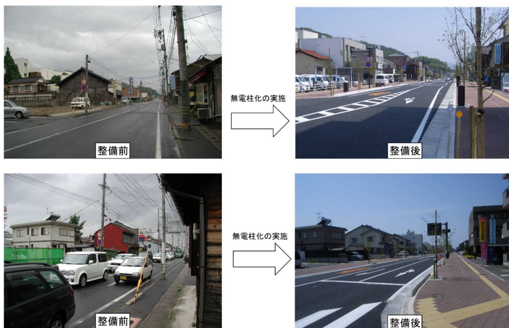
写真1 電線共同溝整備事例（鳥取市内）
