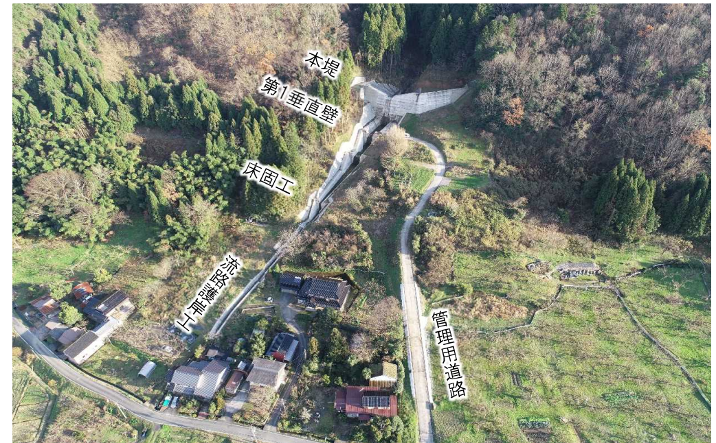
砂防堰堤写真
