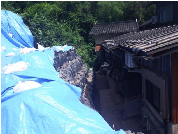
崩落土撤去 斜面下部に大型土のう設置 法面にブルーシート設置
