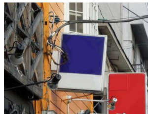
上部構造全体が傾斜した状態
