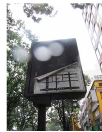
シート材がはがれかかった状態
