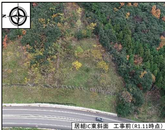
居組IC東斜面 工事前(R1.11時点)
