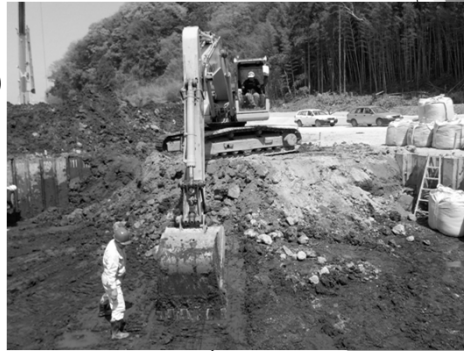
バックホウによる 掘削
