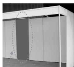
SY-14 壁面カラー工事
