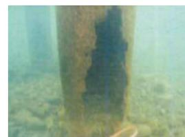
▲橋脚水中部の断面欠損
