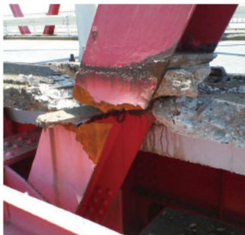
破断した鋼材、上下が完全に分離している
