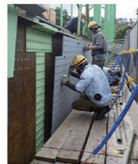
作業風景(当て板補強)
