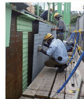
作業風景(当て板補強)
