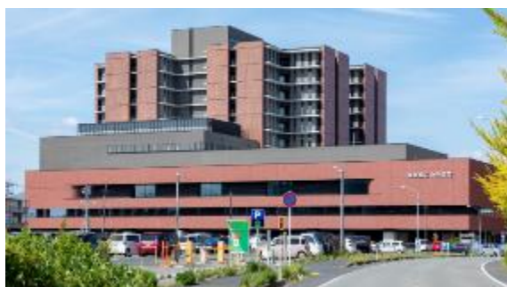
新病院の全景
