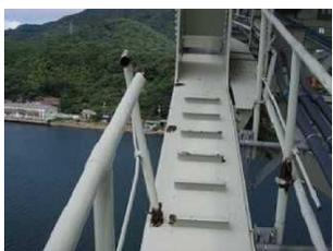
▲ 監査路の腐食・破断状況
