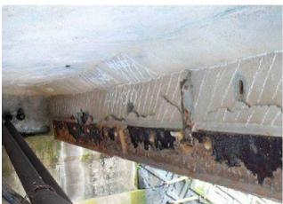
▲ 主桁の損傷状況
