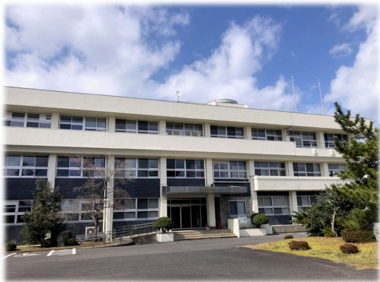
外壁改修工事を行って新しくなった外観（令和 6 年 3 月撮影）
