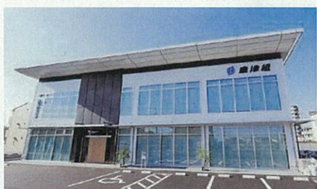
新築した鳥津組の社屋。女性が働きやすいようにハード面も整備した
