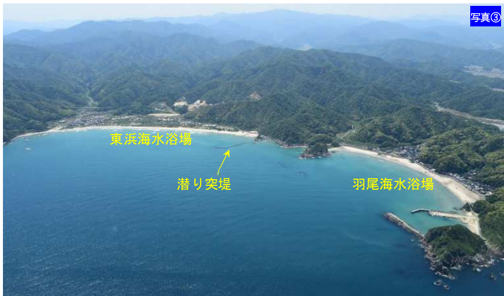
図 4.1.2 岩美海岸（陸上地区）の斜め写真（2019 年 5 月撮影）
