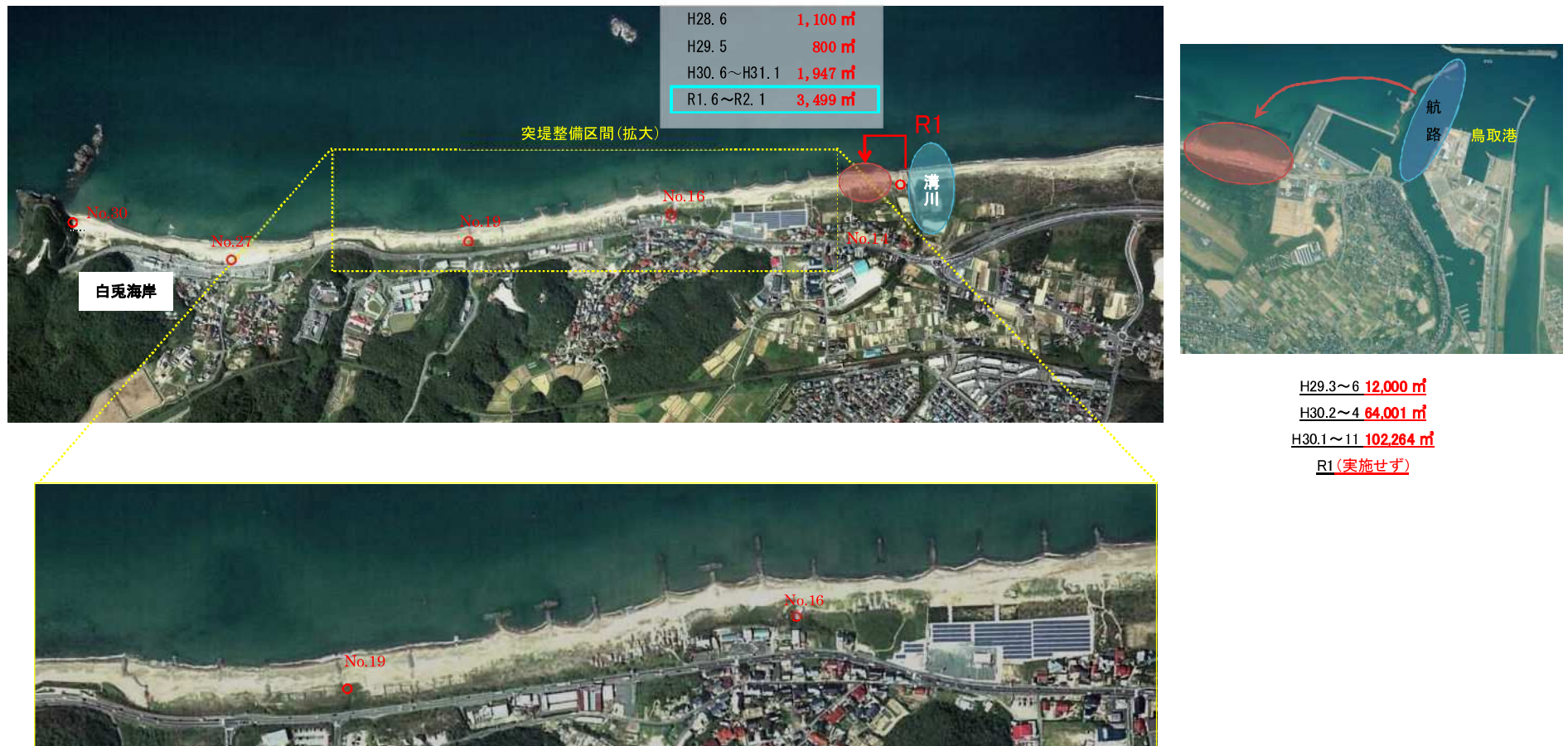
図 4.4.2 白兔海岸における土砂投入状況
