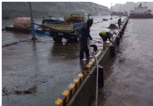
撤去作業状況
