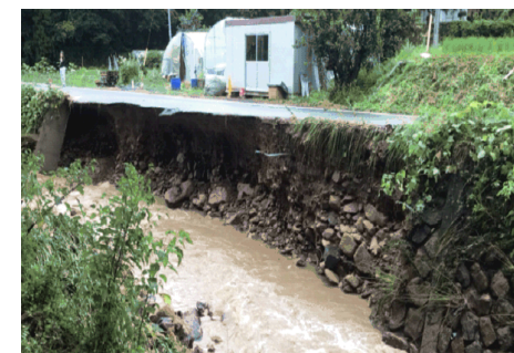
富海川(倉吉市富海)護岸崩落
