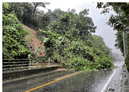
県道倉吉青谷線(湯梨浜町佐美)法面崩落
