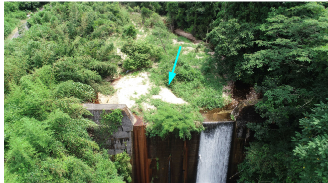
【岩倉川砂防堰堤の堆砂状況】
