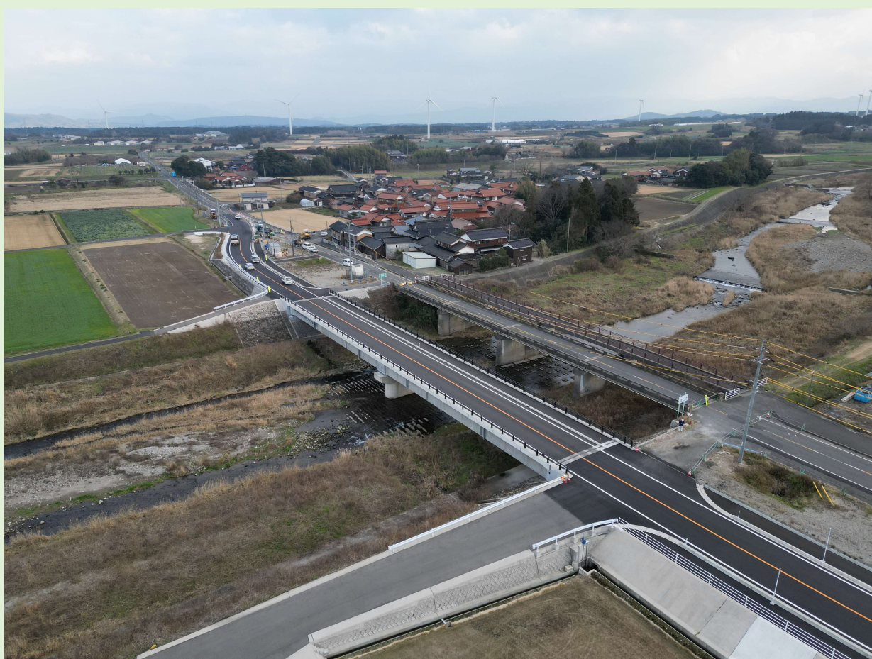
主要地方道 東伯関金線 杉下橋 (R5. 12. 12 供用開始)
